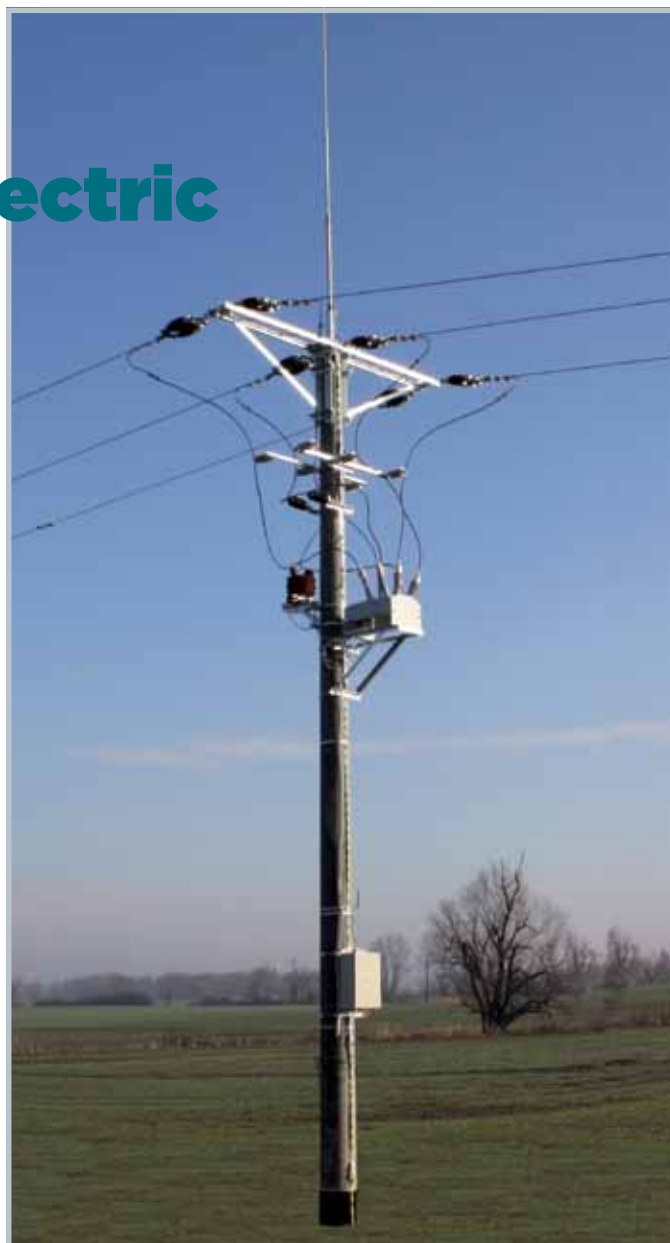
Rys. 1. Stanowisko z reklozorem KTR
