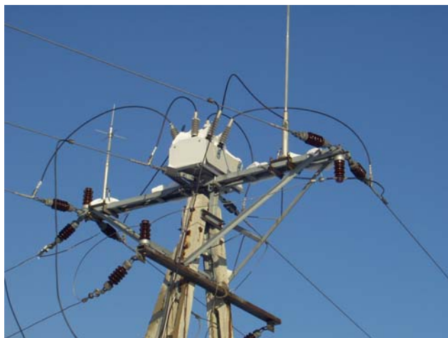
Rys.3 . Brak mechanicznych elementów w sterowaniu zapewnia dużą niezawodność w warunkach zimowych
