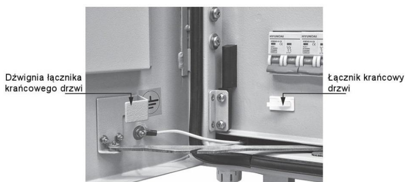
Rys.5.16. Łącznik krańcowy drzwi
