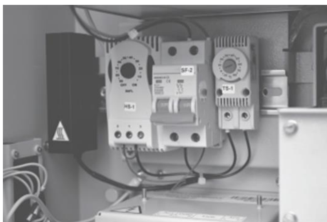
Rys.5.33. Zestaw antykondensacyjny (komponenty elektryczne)
